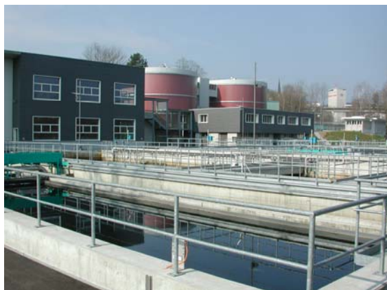
Bassin des boues actives et de la digestion anaérobie
