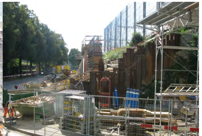
Stützmauer Birsfelder Strasse, Wiederlager Grossbasel
