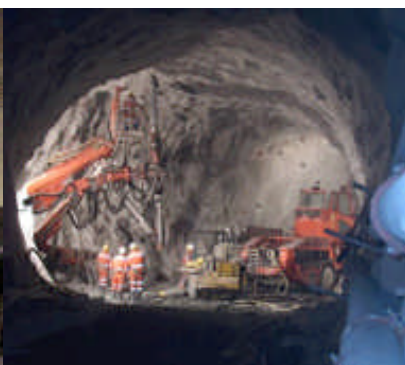
Konventioneller Vortrieb mit Vortriebsausrüstung.
