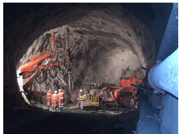
Konventioneller Vortrieb mit Vortriebsausrüstung
