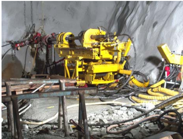
Preventergeschützte Kernbohrung zur Vorauserkundung der geologischen und hydrogeologischen Verhältnisse
