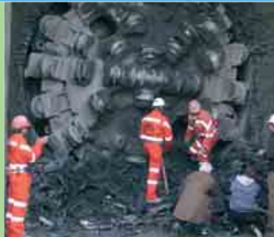
Portail sud de la galerie de sécurité du contournement de Flüelen (2,5 km) (route nationale N4, canton Uri). Cérémonie de percement du tunnel le 21.12.2006 après 7 mois de travaux difficiles.
