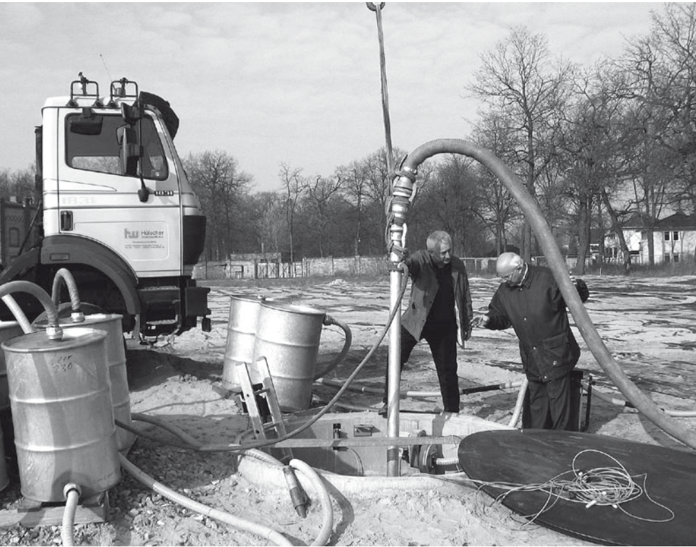
Kieswechsel im oberen Filter eines Grundwasser-Zirkulationsbrunnens mithilfe einer Drucklanze
