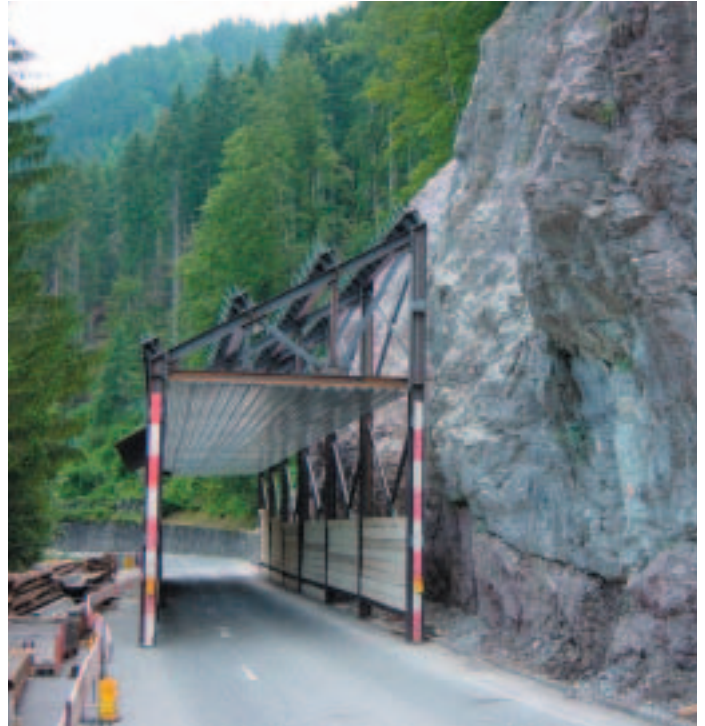
Mise en place d'une galerie de protection provisoire, assurant la sécurité et la continuité du trafic routier à l'abri d'éventuelles chutes de blocs.
