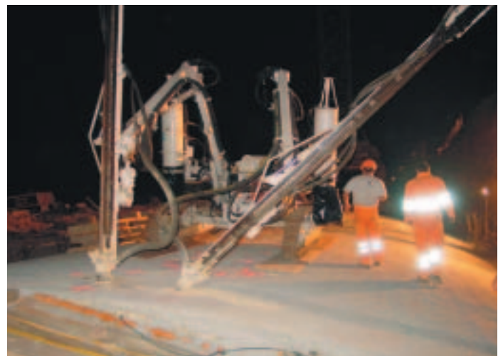
Forages de la voûte pour la mise en place des tirants
