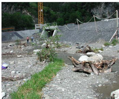
Le ruisseau Allmibach a été détourné en raison de la construction du tunnel de protection contre les avalanches, puis revitalisé.
