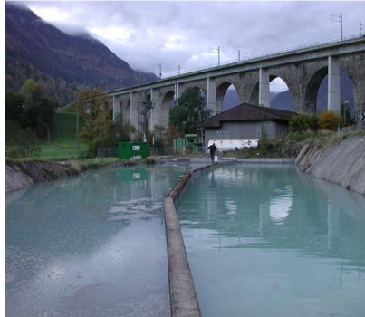
Les eaux usées provenant du tunnel sont neutralisées et décantées avant d'être déversées dans la Kander.
