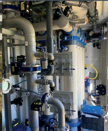
Impianto pilota di nanofiltrazione a Cudrefin, Svizzera
