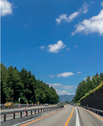
Umweltbaubegleitung A7, Frauenfeld, und A13, Untervaz-Zizers, Schweiz
