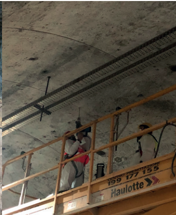
Kontrolle des Zustands der Tunnels der italienischen Autobahnen A7, A10 und A26, Italien
