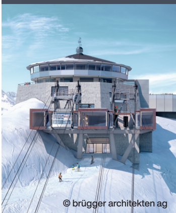
Umwelt- und bodenkundliche Baubegleitung, Luftseilbahn- Neubau Schilthorn, Schweiz
