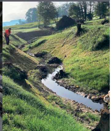
Renaturierung/ Offenlegung des Tramont-Bachs im Jura, Schweiz
