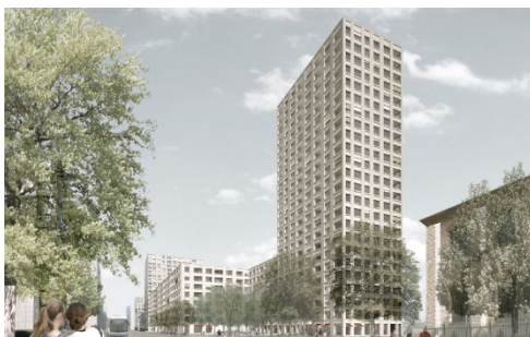
Blick auf das Hochhaus Seite Hohlstrasse
