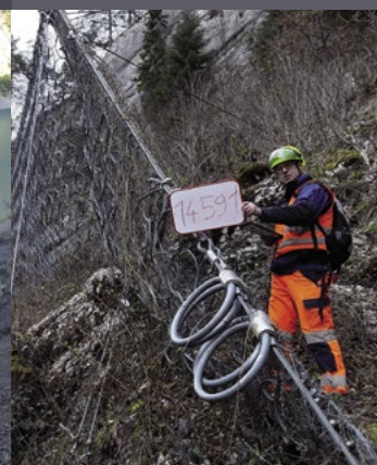
Relevés sur tablettes de terrain des 5000 ouvrages de protection des Chemins de fer fédéraux suisses CFF (CH)
