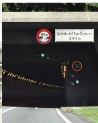
Tunnel du Gothard, 2 e tube, géologue principal, cantons d'Uri et du Tessin (CH)
