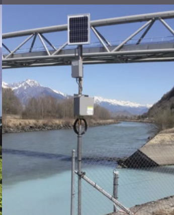
Surveillance du Rhône en utilisant la technologie LoRa, transmission de données à faible consommation d'énergie par radio, Valais (CH)
