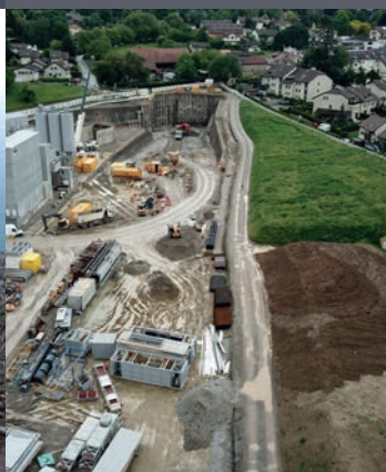
Travaux souterrains, étude et direction des travaux, Tunnel des Nations, Grand-Saconnex, Suisse
