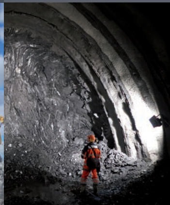
Géologie, gestion des matériaux, planification de décharge, tunnel Albula II, Grisons, Suisse
