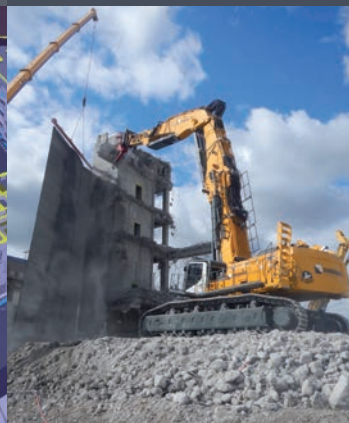
Désamiantage et démantèlement de l'usine Huntsman, Schweizerhalle, Suisse
