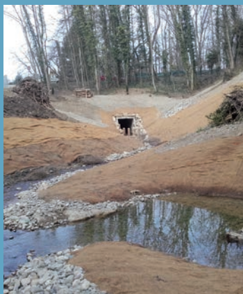
Renaturation, reconstruction du lit du cours d'eau au Nant d'Aisy, Genève, Suisse
