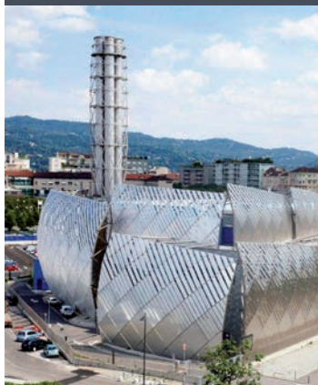
Chauffage à distance, modernisation structurelle d'une chambre à vannes, Turin, Italie
