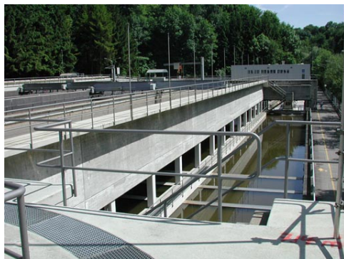
Bild links: Bestehende biologische Reinigungsstufe mit Vorklärbecken (links), Belüftungsbecken (Hintergrund) und Nachklärbecken (rechts)
