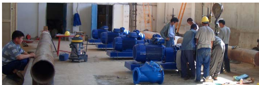
Le souci de formation du personnel local a dicté son implication dès la phase de montage.
