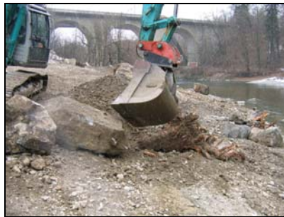
Einbau der Wurzelstöcke zur Aufwertung der Strukturevielfalt im Nieder- und Mittelwasserbereich
