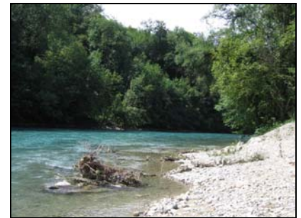
Rauhaumbühne nach Realisierung, Bühne hat keine hydraulische Funktion sondern bezweckt lediglich eine Aufwertung der Fließstrukturen
