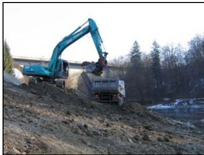
Abflachung Gleitufer
