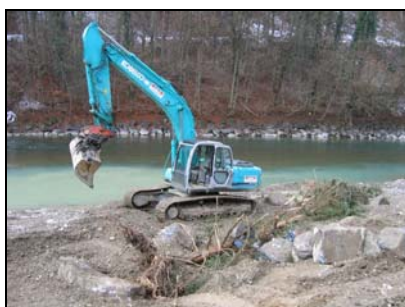
Bau der deklinanten Rauhaumbühne
