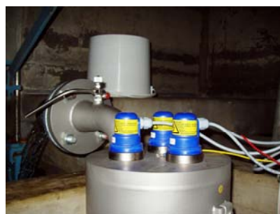
Dettaglio lampada UV (attacco lampade)
