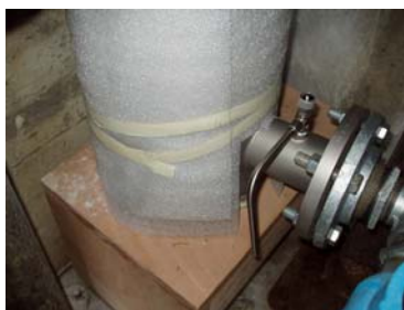
Dettaglio lampada (ingresso)
