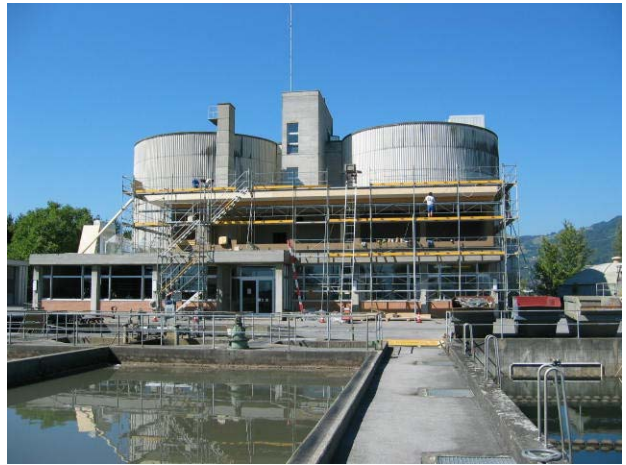
Betriebsgebäude mit Erweiterung und Faulanlage
