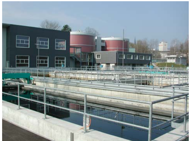
Neues Schlammentwässerungsgebäude, Betriebsgebäude und Faulräume, davor Belebtschlamm-Biologie
