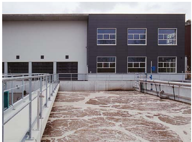
neue Belebtschlamm-Biologie für C-Abbau, Nitrifikation und Denitrifikation, sowie Teil Bio-P
