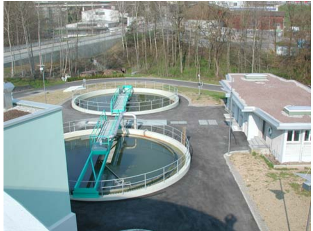
Phostrip-Anlage mit Rücklöse und Fällreaktor sowie Frischschlammvorversäuerung
