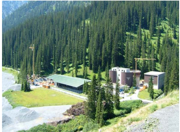
Gesamtansicht der ARA Arosa
