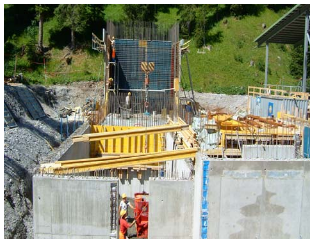
Biofiltration für weitergehende Nährstoffelimination
