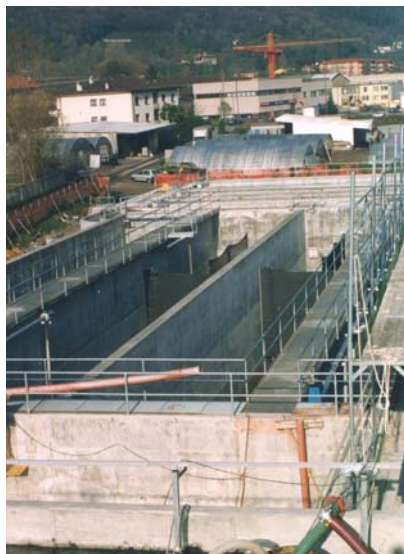
Veduta del cantiere: nuove vasche per il trattamento biologico
