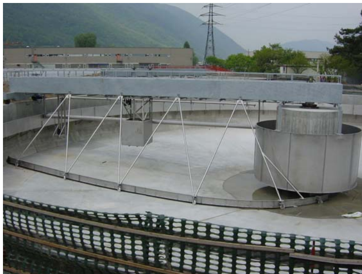
Bacino circolare Schreiber riconvertito in chiarificatore finale.
