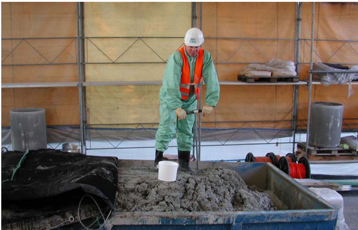
Prélèvement d'échantillon des matériaux excavés lors de la construction des infrastructures
