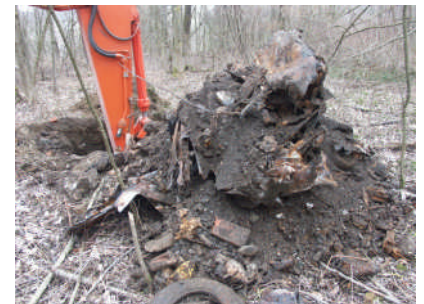
Sondage à la pelle hydraulique dans le corps de la décharge
