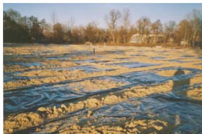
Verlegen der Abdeckfolie (Fläche 9.500 m 2 ) zur Unterstützung des mikrobiellen Abbaus in der Bodenluft und Verhinderung des Schadstoffaustrittes in die Atmosphäre (Dezember 2003) .
