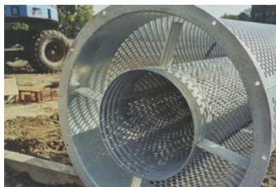
Lieferung des Bodenstützfilters (obere Filterstrecke) zur Errichtung des GZB im nördlichen Bereich des Sanierungsgeländes (Durchmesser 800 mm) im Oktober 2003
