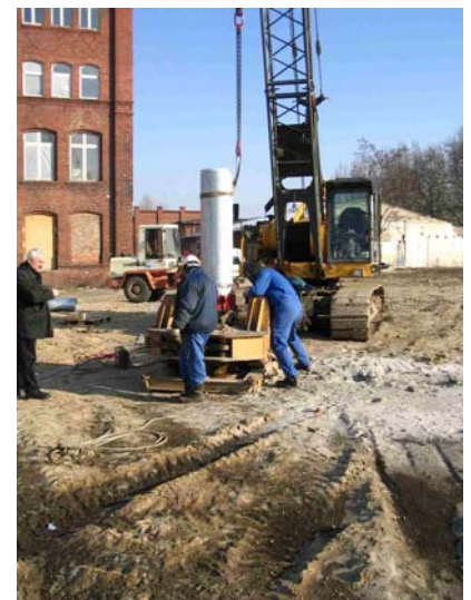
Errichtung des zentralen GZB im südlichen Bereich des Sanierungsgeländes (Durchmesser 800 mm) im Januar 2005
