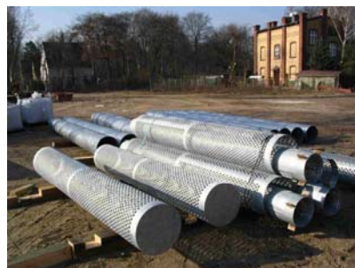
Lieferung der Bodenstützfilter (untere Filterstrecke) zur Errichtung des GZB (Durchmesser 400 mm) im Januar 2005. Erweiterung der Sanierung auf den südlichen Bereich des Geländes.
