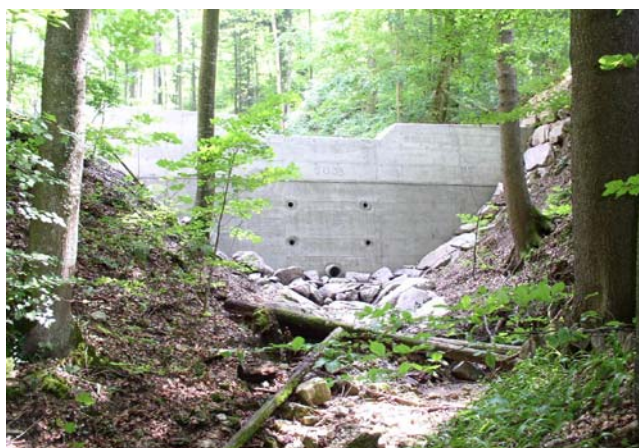
Bachsperre Ansicht Luftseite (von Norden)
