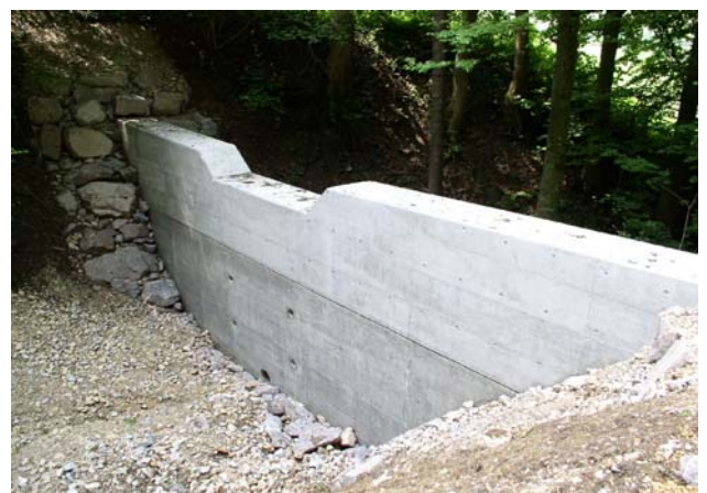
Bachsperre Ansicht Wasserseite (von Südosten)
