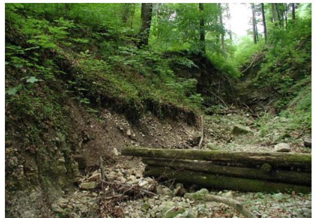
Ansicht des Murenbachs bachaufwärts (nach Süden) mit alten Holzschwellen
