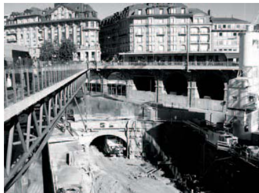
Front d'attaque du tunnel de St.-Laurent
