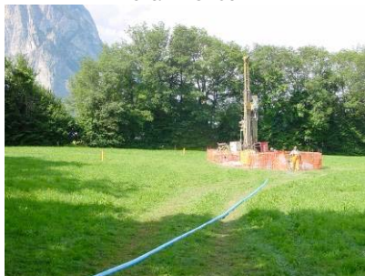
Investigations hydrogéologiques complémentaires (essai de pompage)
