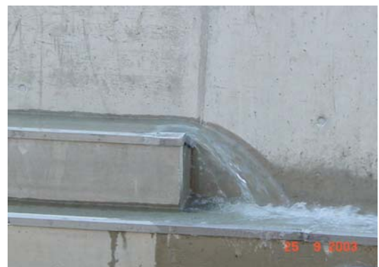
Mise en eaux du mur et vérification du fonctionnement des « marches »
