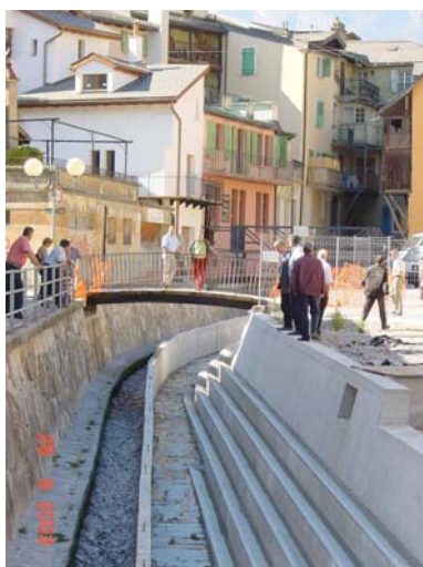
Déviations de la Sionne en rive gauche pour permettre le travail au sec sur la rive gauche
