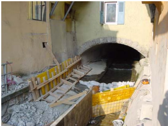
Déviations de la Sionne en rive gauche pour permettre le travail au sec sur la rive gauche
