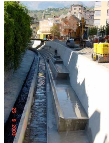
Mise en eaux du mur et vérification du fonctionnement des « marches »
