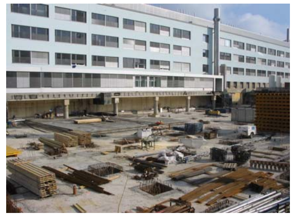
La mauvaise qualité du terrain a nécessité la réalisation d'un radier reposant sur 240 pieux
