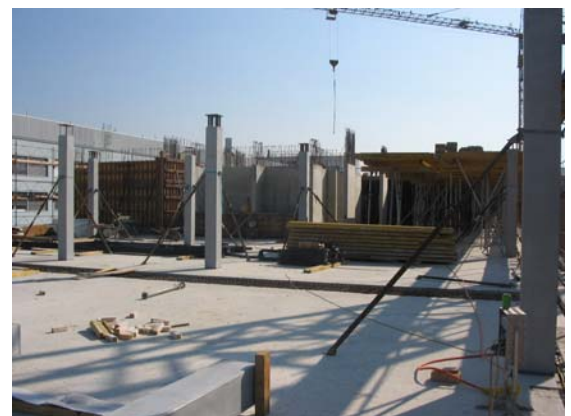
Mise en place des piliers préfabriqués
