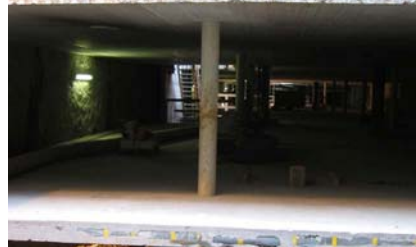
Provisorische Abspannungen auf den Stirnseiten des Parkhauses. Die Deckenrampen für die Ein- und Ausfahrt des Parkhauses wurden von unten nach oben erstellt, nach Beendigung des Gesamtaushubs
