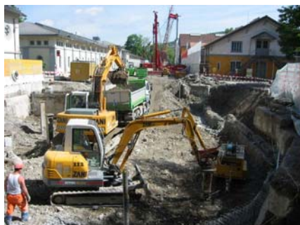
Voraushub zum Erstellen der Deckplatte
