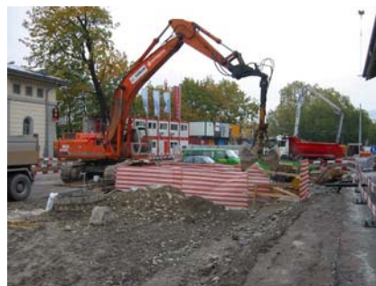
Montageöffnung zum Abtransport des Aushubmaterials
