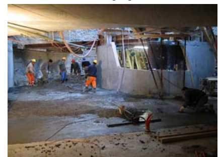
Provisorische Abspannungen auf den Stirnseiten des Parkhauses. Die Deckenrampen für die Ein- und Ausfahrt des Parkhauses wurden von unten nach oben erstellt, nach Beendigung des Gesamtaushubs
