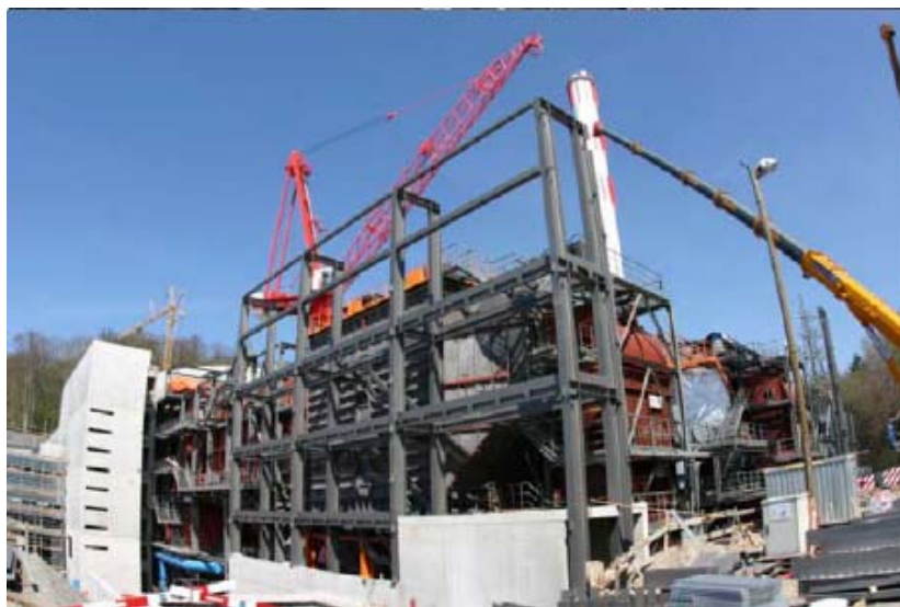
Edificio della zona forni: struttura portante durante la fase di realizzazione
