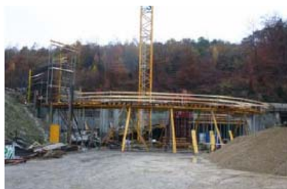
Rampa d'accesso per l'alimentazione dei rifiuti
