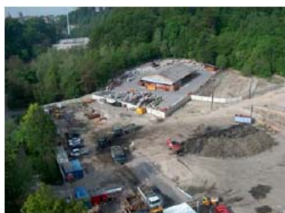
Preparazione del cantiere
