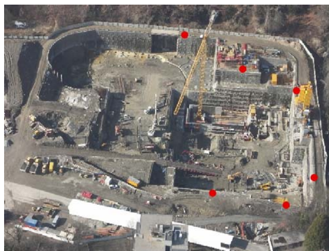
Centre d'incinération Tridel, Lausanne : situation des points de contrôle inclinométriques en bordure de fouille
