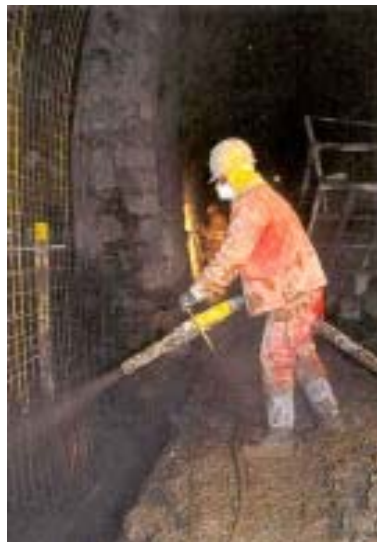
Ricostruzione di un piedritto con calcestruzzo spruzzato
