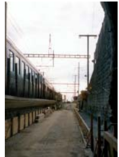
Abbassamento della platea e sistemazione del portale
