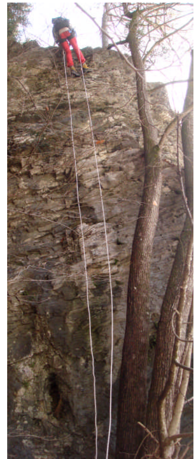
Geologische und felsmechanische Aufnahmen in der Felswand für die Situationsbeurteilung.
