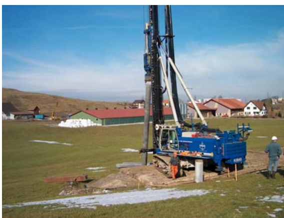
Pfahlramme im Einsatz
