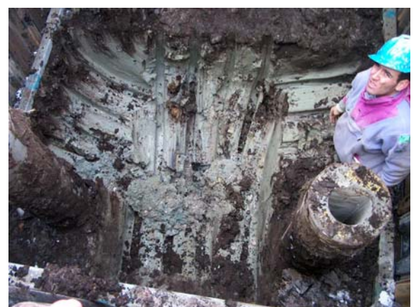
Aushub für Köcherfundament nach Rammen der Pfähle
