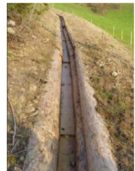
Canal du Trapez pour l'écoulement dans la pente
