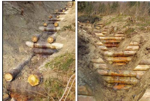
Écoulement du Zopfbach (gauche) et aménagements sur le Büelbach (droite)
