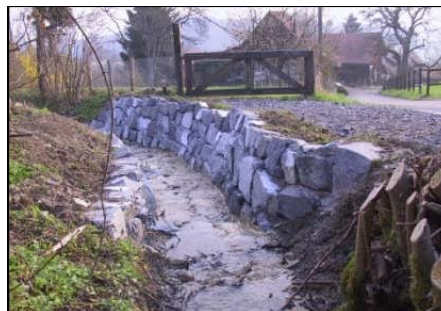
Renforcement des berges de la Schürbach
