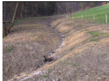
Canal d'écoulement dans le secteur de l'effondrement du sol
