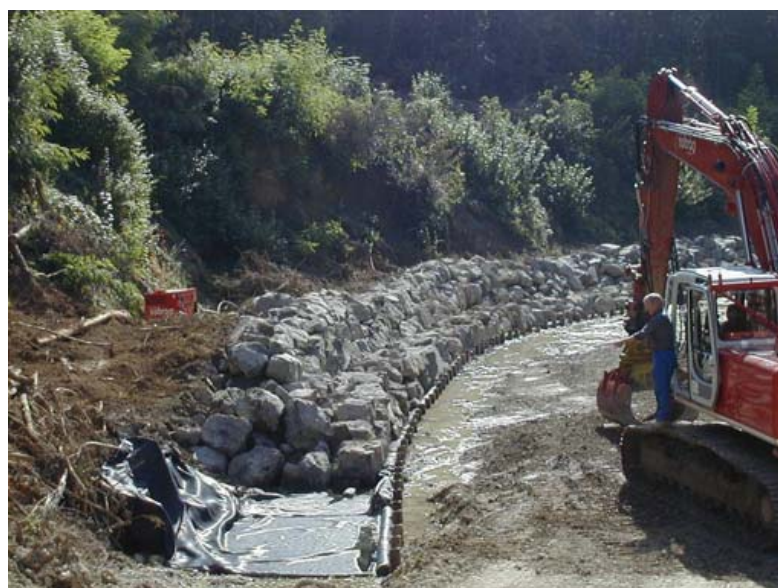
Esecuzione della scogliera
