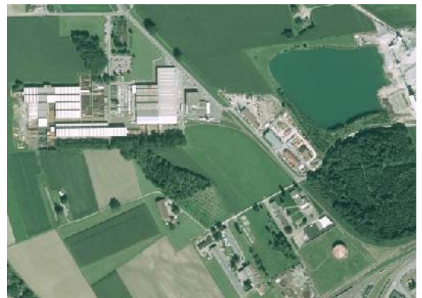
CSD soutient le maître de l'ouvrage dans sa prise de décision quant aux choix énergétiques (pompage ou sondes géothermiques) en fonction des potentialités et recommandations pour l'exploitation à long terme.
