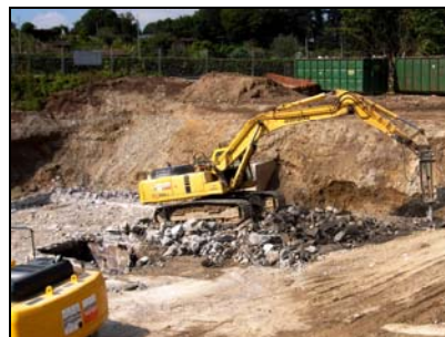
Abbruch Bodenplatte des alten Betriebsgebäudes mittels Hydraulikhammer
