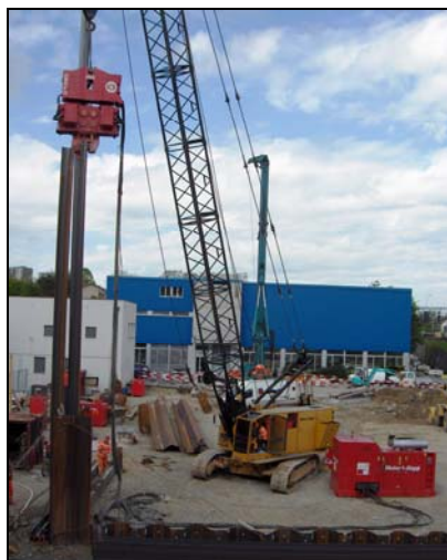
Einvibrieren einer Bohle, Vibroramme Typ IEC 28-RF
