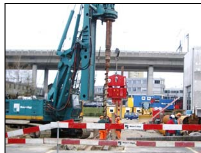
Erstellen überschnittene Bohrpfahlwand, Bohrmaschine C30
