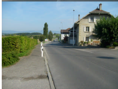
Vues sur la RC251a dans le village de Mex (tronçon à assainir)
