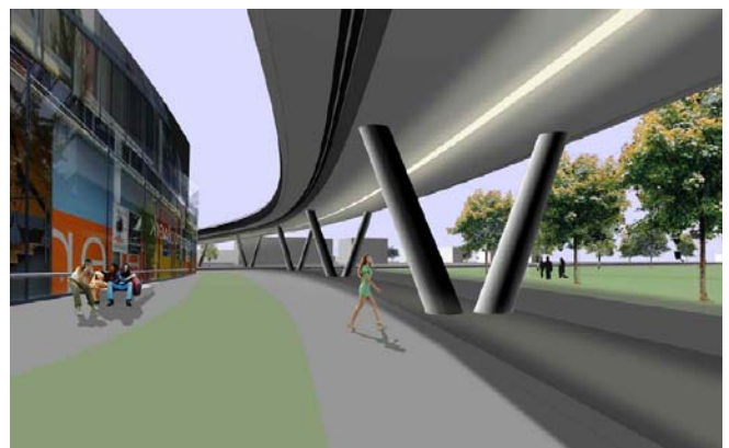
Abbildung oben: Visualisierung der Brücke im Endausbau des Quartiers Loren. Dank der Gestaltung von Brückenquerschnitt und Stützen wird eine massige Wirkung des Bauwerks vermieden.
