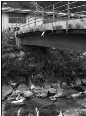
Exemple - Système d'alerte mis en place dans le cadre du concept d'alarme de Realp (Uri): redondance du signal aux points faibles par 2 radars de mesure et 1 caméra avec éclairage; acquisition d'informations à l'amont hydrologique par 2 stations pluviométriques avec mesure de la température. La transmission des paramètres depuis le terrain dans la base de données des décideurs se fait automatiquement via fibres optiques (ligne fixe) et liaison GSM.
