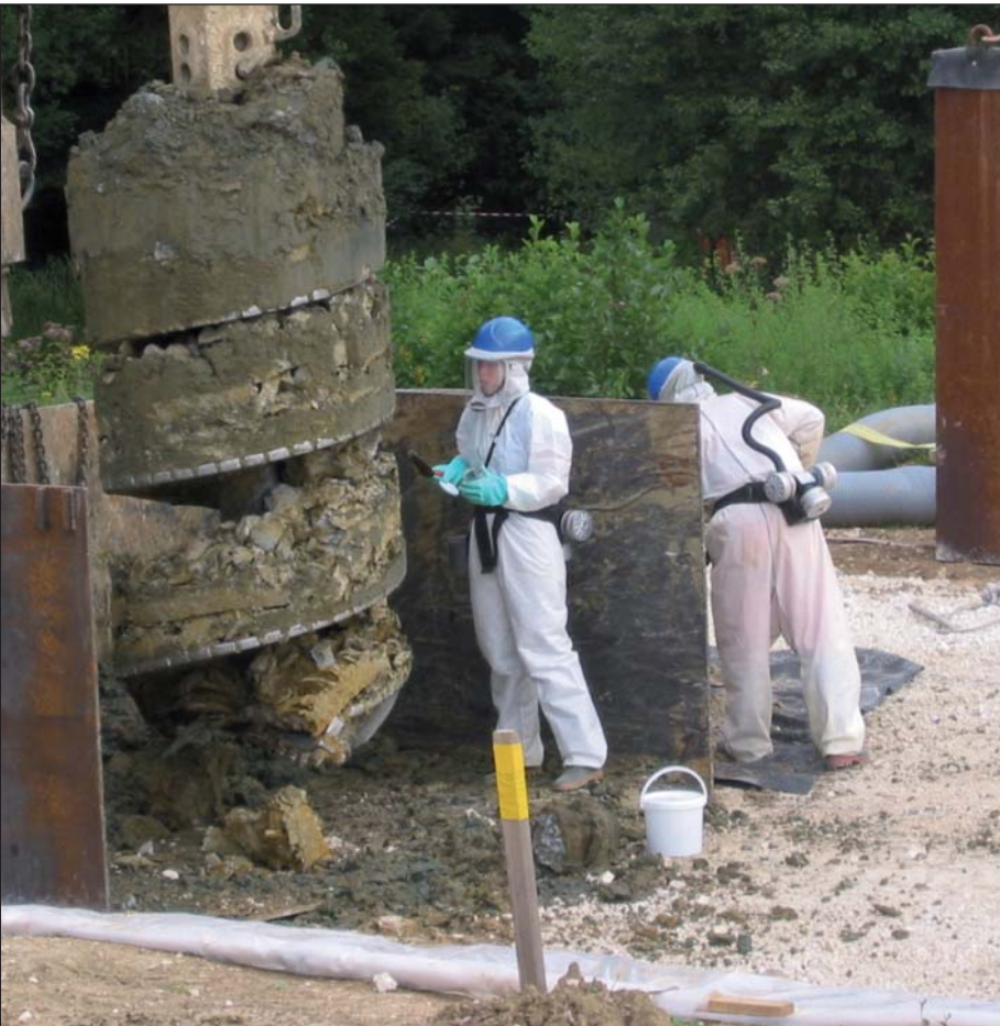
Figure 2: Suivi des travaux de mise en place des pieux de fondation de la halle d'excavation: les matériaux sont triés puis évacués en fonction de leur degré de contamination sur la base des résultats d'analyses réalisées sur les échantillons prélevés.
