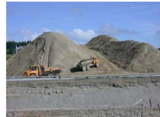
Materialbewirtschaftung Baustelle Brünnen
