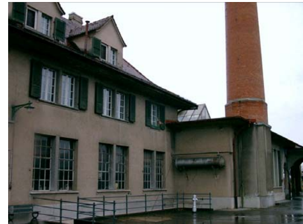
Schlachthof vor dem Rückbau
