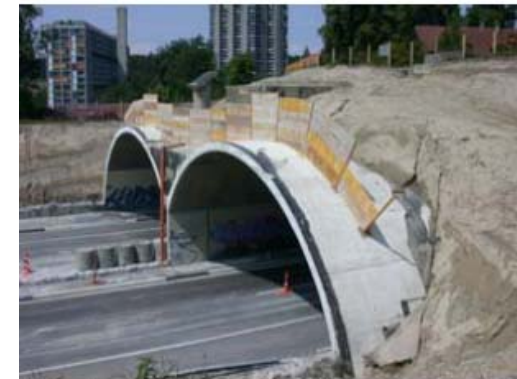
Bau der Verlängerung der Autobahnüberdeckung
