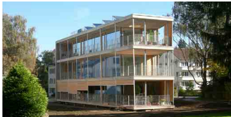
BE-001-P-ECO: MFH Gebhardstrasse 15 Leibefeld Bauherr: STOWE Gebhartstrasse 15 Architekt: Halle 58 Architekten
