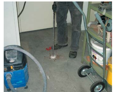
Abbildung 3: Erstellung Bohrloch für Entnahme Bodenluftprobe (SP5)
