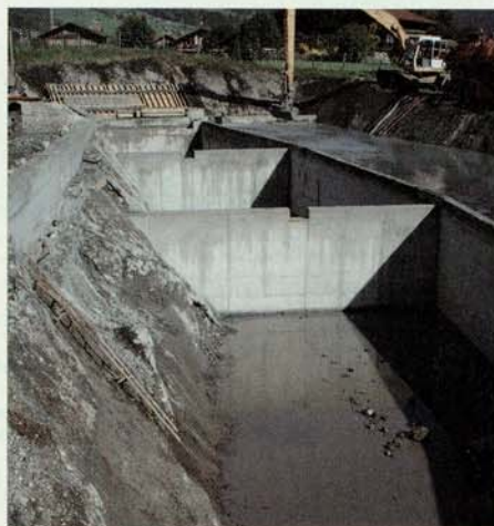
Abb. 3: Die öBB als Fachbauleitung: weisend und ausführend.
