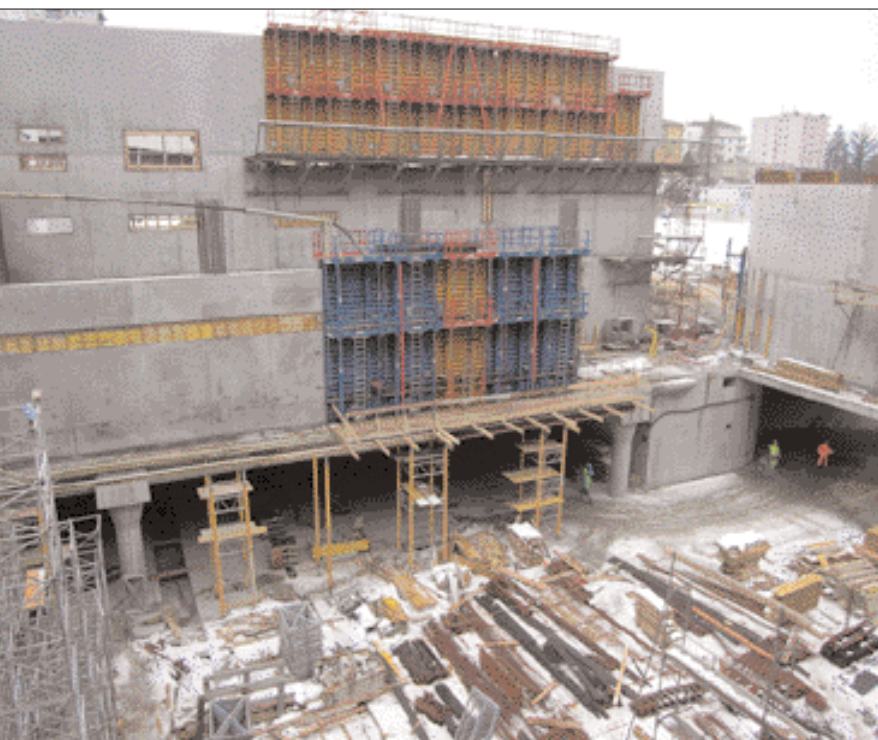
Deux lignes de feu en cours de montage.
