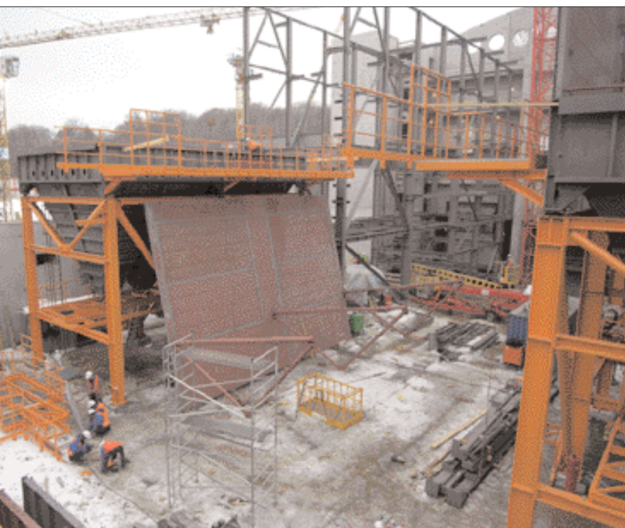
La fosse à déchets vue depuis la gare ferroviaire. Cette dernière comprendra deux voies pour permettre la manoeuvre des trains.
