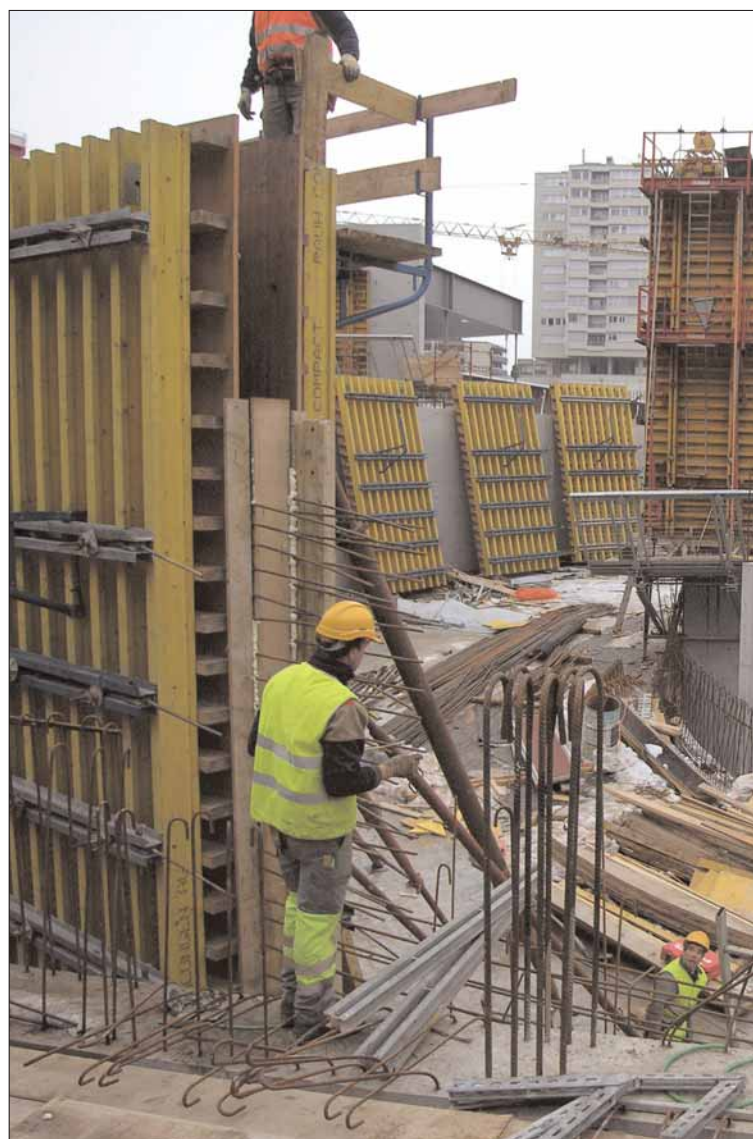
Mise en oeuvre de la rampe d'accès.
