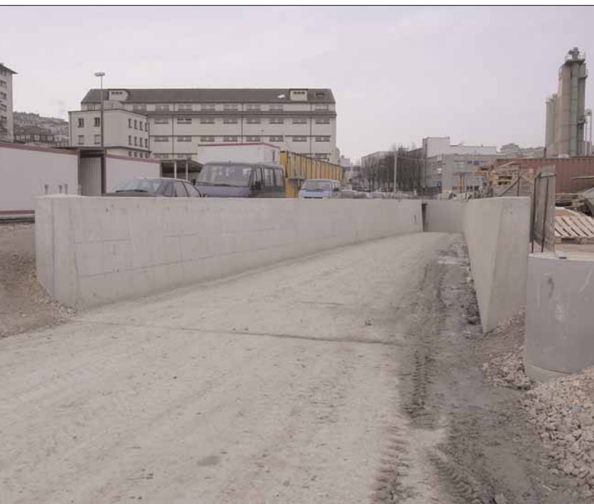
Trémie d'accès du tunnel de Sébeillon, reliée à la ligne CFF.
