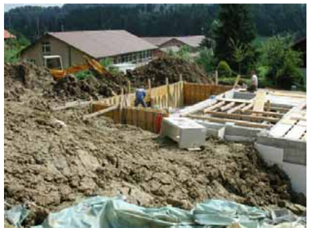
Foto 4.6: Etappenweiser Bau Kellergeschoss
