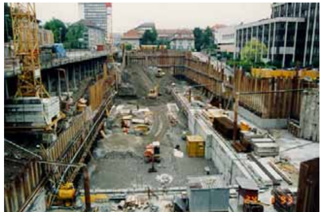
Foto 4.8: Blick von der Bovetstrasse in die Baugrube
