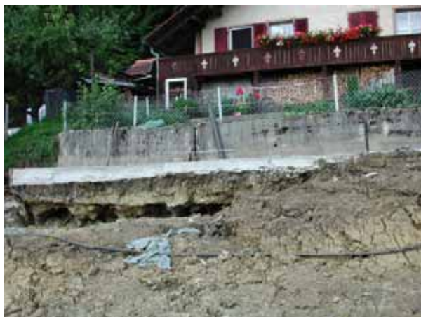
Foto 4.5: Zustand bei Mauerstabilisierung
